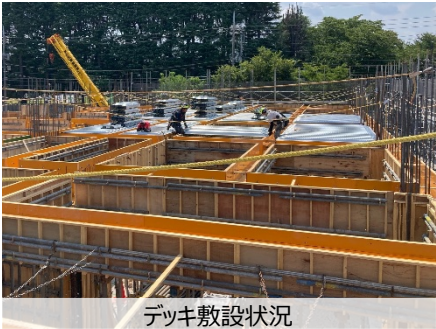
デッキ敷設状況
