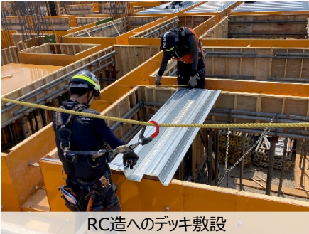
RC造へのデッキ敷設
