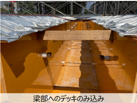
梁部へのデッキのみ込み
