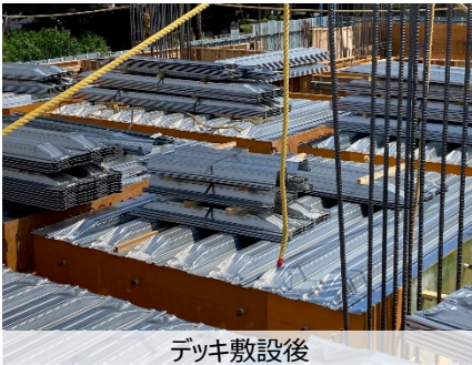
デッキ敷設後
